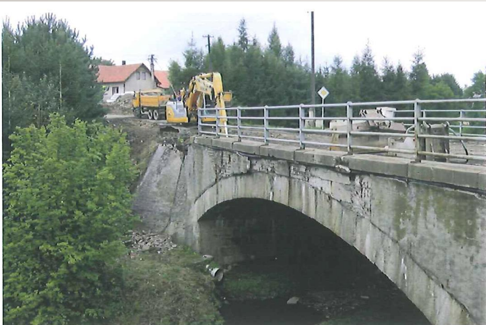
Foto 1 [14.8.2014 10_13 Krupička] Pohled proti staničení; zahájení odtěžování pravé strany silničního tělesa za opěrou č. 1 dne 14.8.2014; foto pořízeno v čase 10:13
